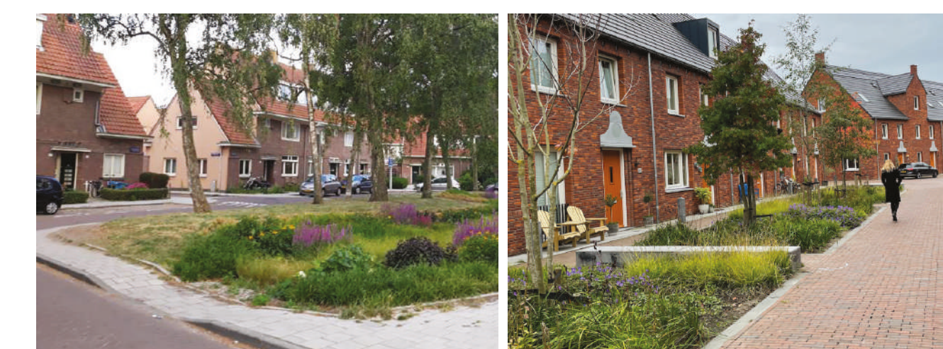
Aflopen regenwater naar plantsoenen Aflopen regenwater naar groene tuinen op de stoep
