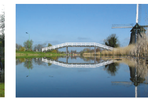
referentie watergang met wandelbrug
