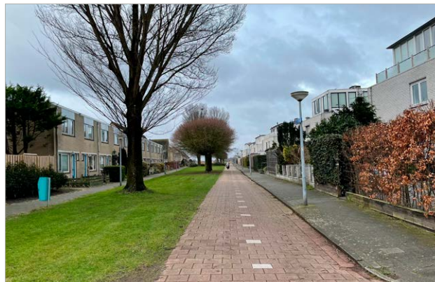
Weinig aantrekkelijke entrees; terrein opgedeeld
